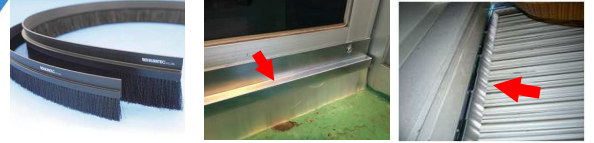
写真1：防虫ブラシ 写真2.3：工場での設置写真
