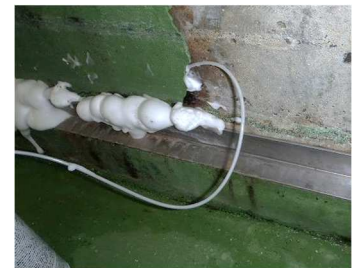
図3：チューブを使いコンクリートの隙間へムースを注入
