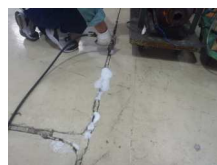
図6：コンクリートとコンクリートの間の木材への薬剤投与
