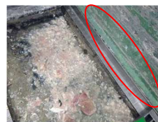
←図1 施工前 排水溝近く（赤丸部分）に割れ目があり、残渣が溜まってチョウバエが発生。
