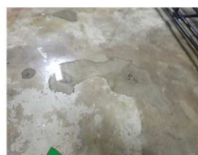
図3 施工前→ 床材が剥がれて滑りやすくなり、台車荷物が転倒し、労働災害になった。
