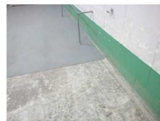
図3 施工前→ 床材が剥がれて滑りやすくなり、台車荷物が転倒し、労働災害になった。
