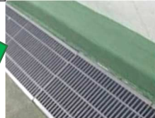
図2 施工後→ 塗床施工し、平滑で汚れが溜まりにくくなった。
