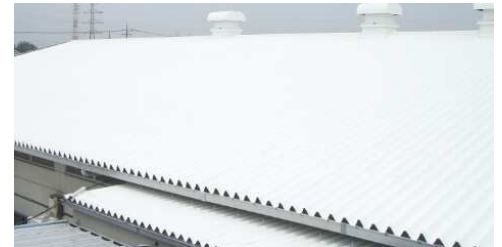
写真1：施工の一例（屋根）
