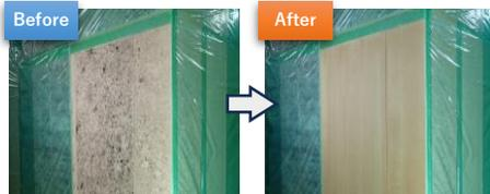
図1 モルテスによる施工前(左)と施工後(右)の様子
