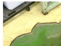
図1：剥がれが生じた塗床
